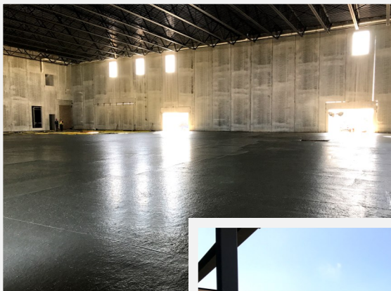
Gym Slab On Grade Pour
